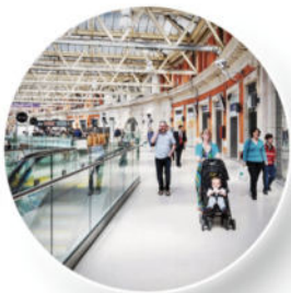
Zábradlí z bezpečnostního lepeného skla
