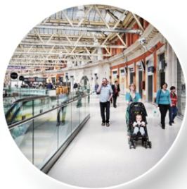
Zábradlí z bezpečnostního lepeného skla
