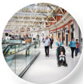
Zábradlí z bezpečnostního lepeného skla
