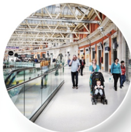
Zábradlí z bezpečnostního lepeného skla
