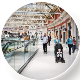
Zábradlí z bezpečnostního lepeného skla
