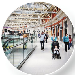
Zábradlí z bezpečnostního lepeného skla
